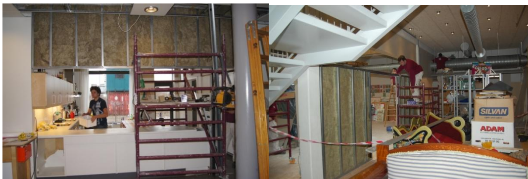
Billeder fra byggeprocessen i Nord og på Potteskåret
